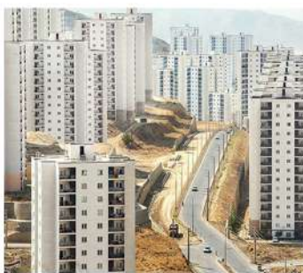
پروژه ۴۵۰ واحدی پردیس تهران - پردیس
